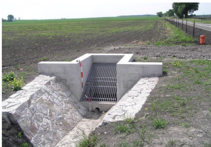
Obr. 11. SO 2 vtokový objekt
