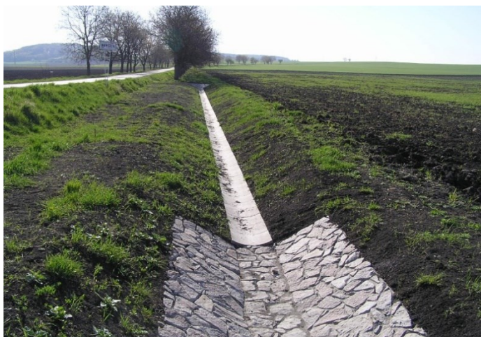
Obr. 10. Stav SO 1 - záchytného příkopu při kolaudaci
