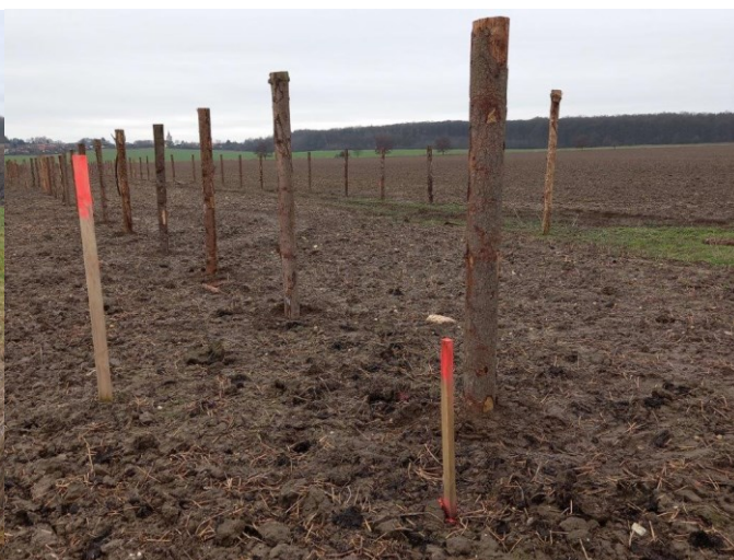
Větrolam TEO2 – geodet. vytyčení a příprava kůlů
