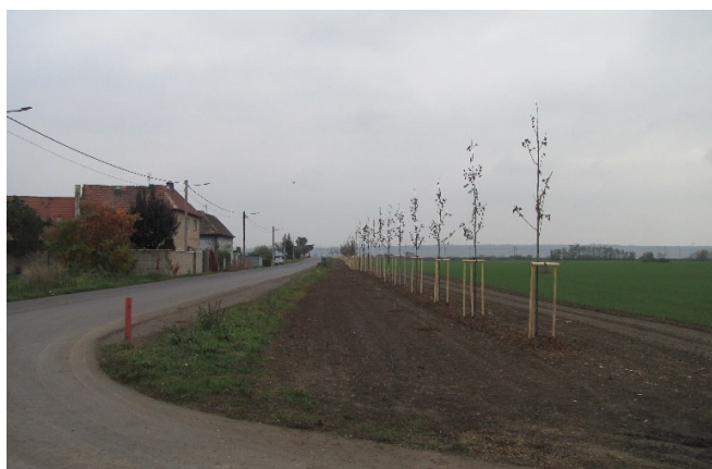
Větrolam IP4 – STAV V PRŮBĚHU REALIZACE:
