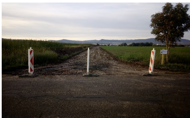
Polní cesta VPC 5.1. – STAV V PRŮBĚHU REALIZACE:
