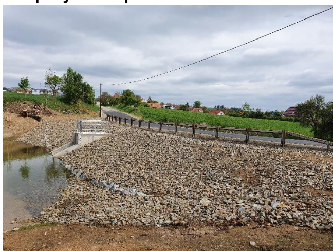
Postupné zavodnění rybníčku po realizaci
