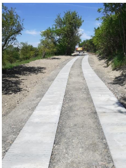
Terénní úpravy C7 Doubravany
