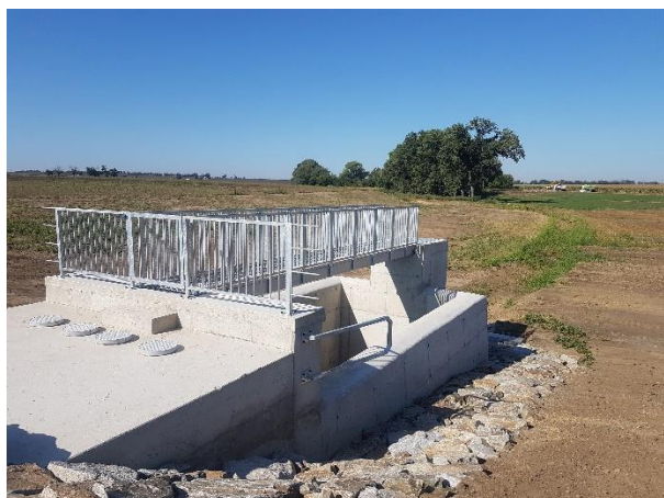
Výpustný objekt a zátopa po realizaci
