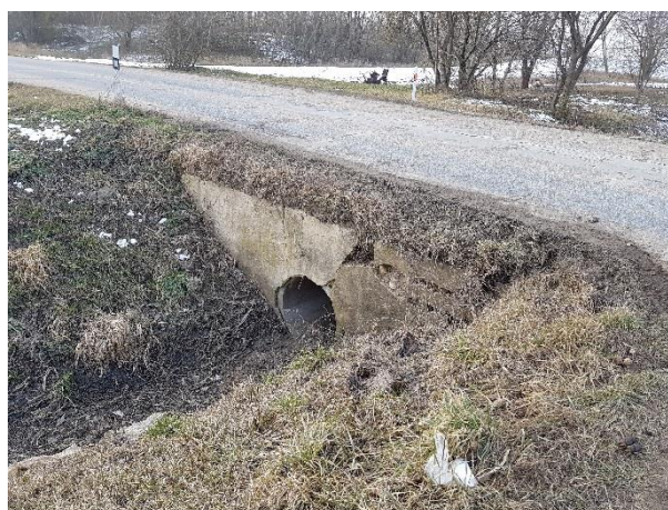
Propustek - před realizací
