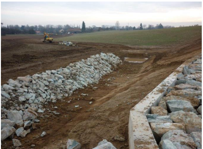
Práce pod hrázi poldru a bezpečnostní přeliv
