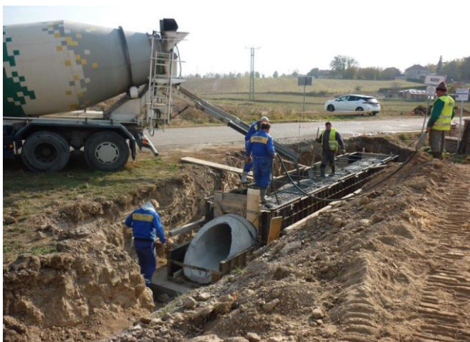
Zemní práce na propustku cesty DO 12b Rodov
