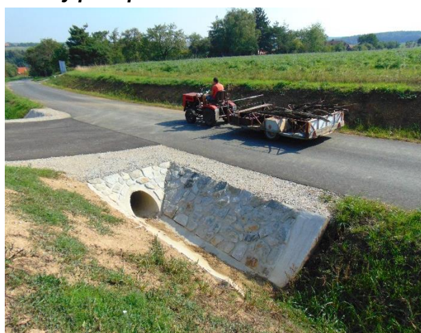
Svodný příkop VH4 na cestě HC4
