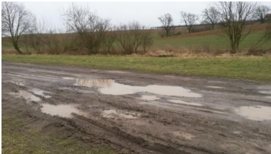
CESTA C3 V PRŮBĚHU REALIZACE
