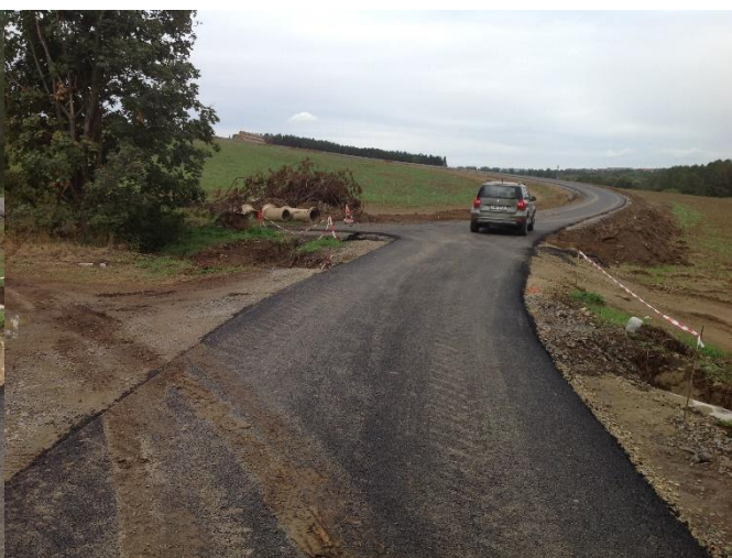
Výstavba polní cesty
