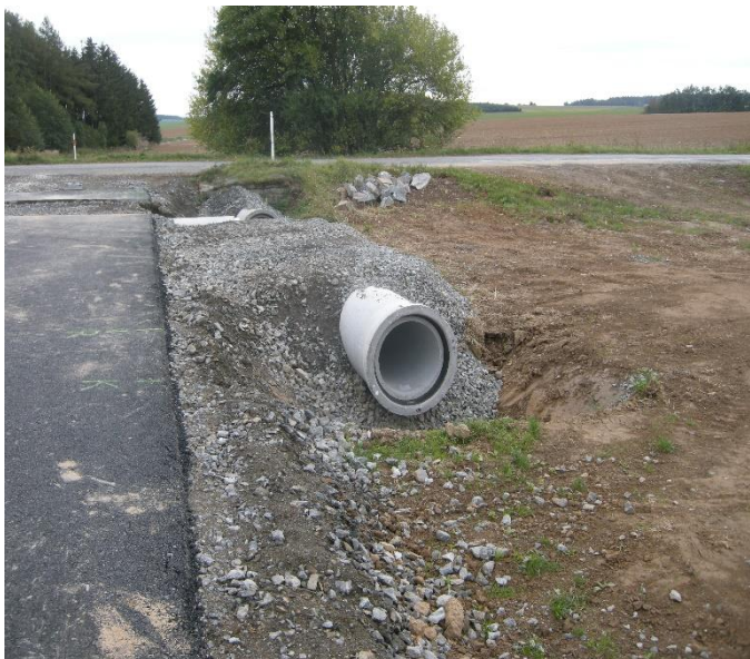
Výstavba polní cesta C11
