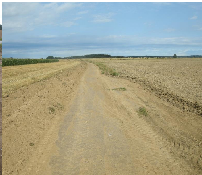
Výstavba polní cesta C11
