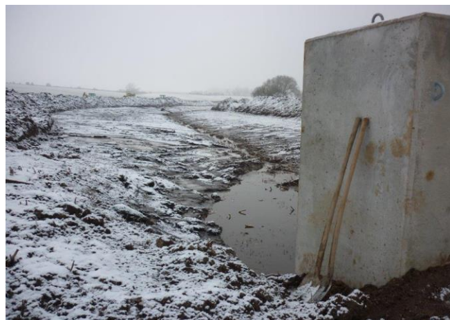
Prostor budoucí zátopy malé vodní nádrže, vpravo je již usazen dvoudlužový betonový monolit požeráku
