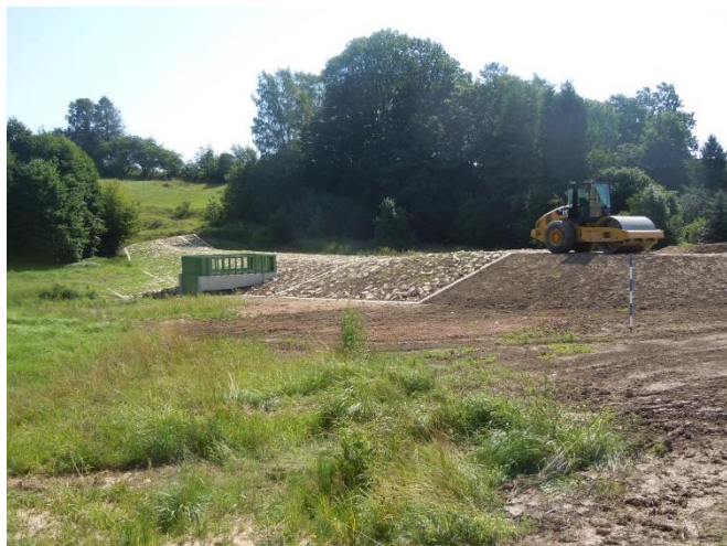
z kamenného záhozu a betonovým prahem.
