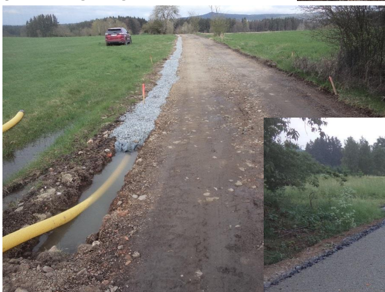
STAV V PRŮBĚHU REALIZACE:
