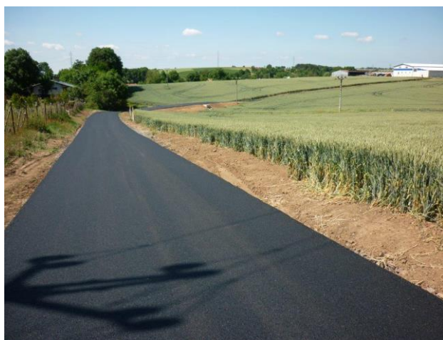
Provádění asfaltobetonového povrchu na Záhumní cestě, vedoucí v koruně Poldru č. 1 – Nad Obcí v k.ú. Sendražice u Smiřic – červen 2017
