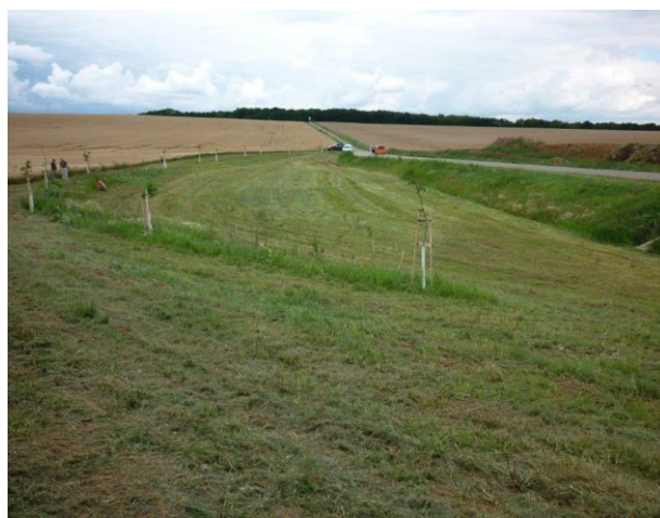
Poldr č. 2 – V Dolinách po realizaci, zatravnění a výsadbě autochtonních dřevin v červenci 2017
