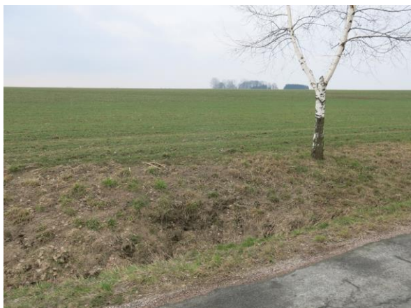
příkop se zatravněním
