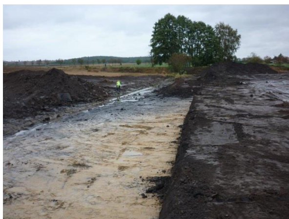
Práce na snímání zemin v tělese zátopy
