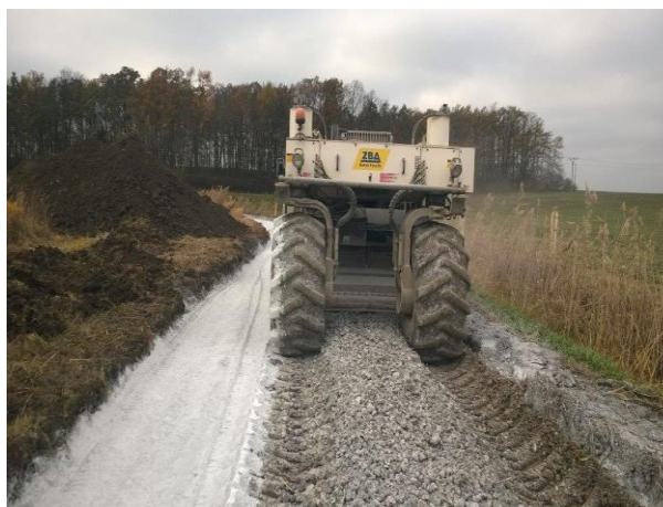
Provádění vápnění jílovitého podloží cesty C11
